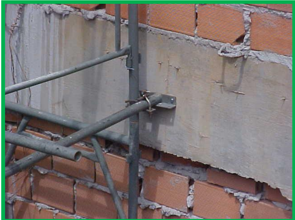
FOTO Nº 03 ANDAIME FACHADEIRO com tubo metálico, abraçadeira metálica, perfil L metálico e bucha metálica.
