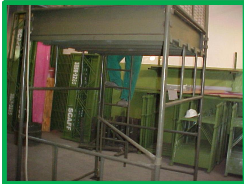
FOTO Nº 08 Funcionário utilizando a escada de acesso.
