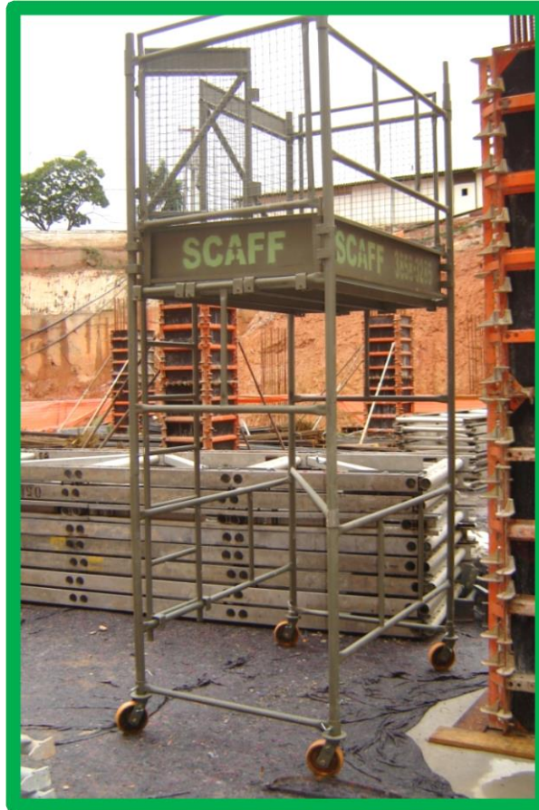
FOTO Nº 21 Andaime posicionado ao lado da forma do pilar. Uso de rodízios em substituição às sapatas.
