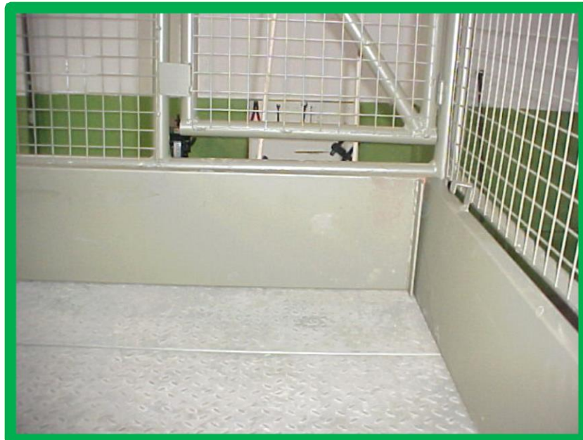
FOTO Nº 14 Porta de acesso, rodapé, piso metálico e guarda-corpo.
