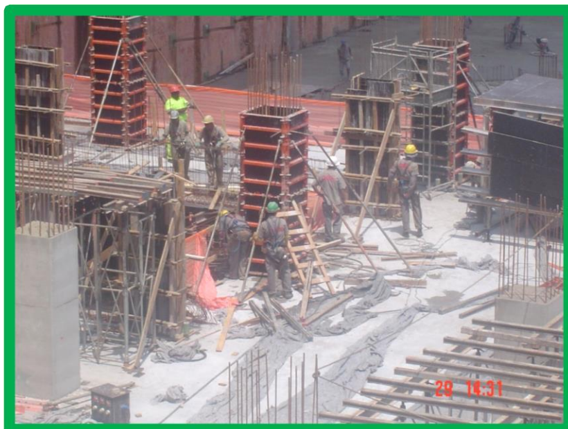
FOTO Nº 23 Andaime posicionado ao lado da forma do pilar.
