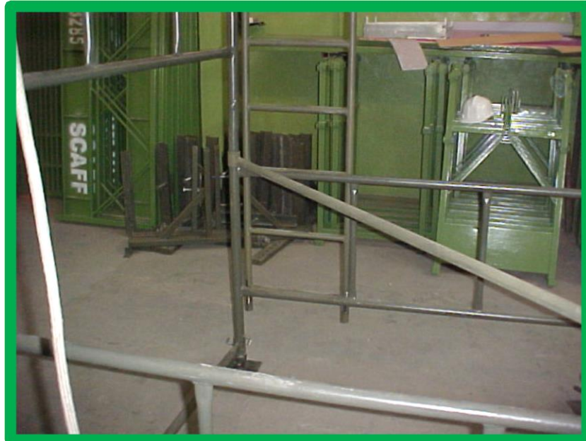
FOTO Nº 06 Escada de acesso.
