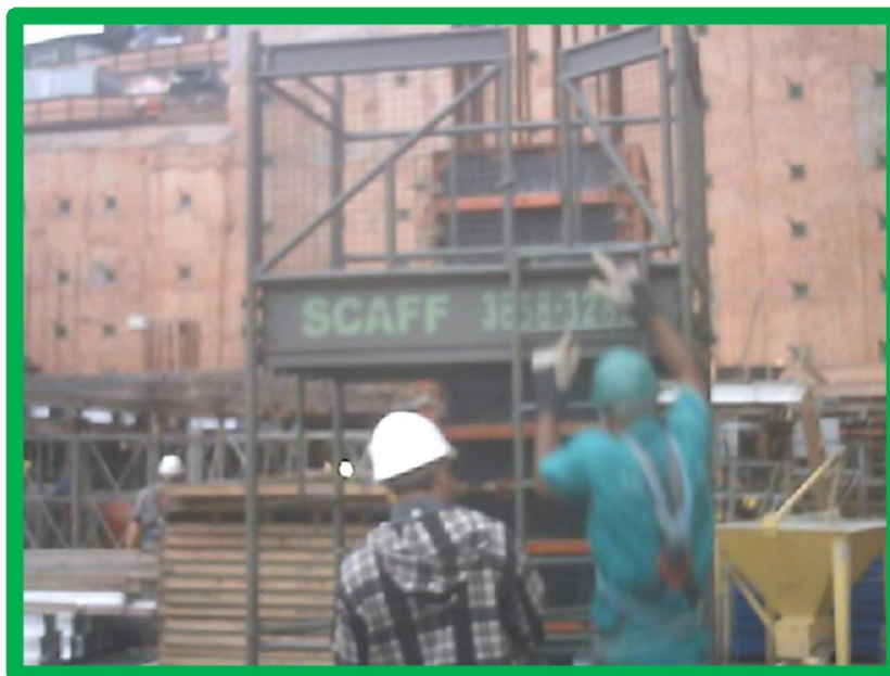
FOTO Nº 22 Funcionário acessando o andaime.
