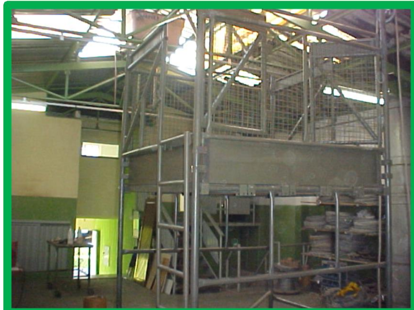
FOTO Nº 07 Escada de acesso, rodapé e guarda-corpo.
