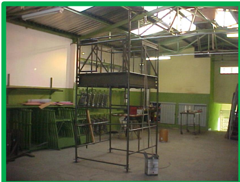
FOTO Nº 02 Andaime com porta de acesso e porta para içamento.
