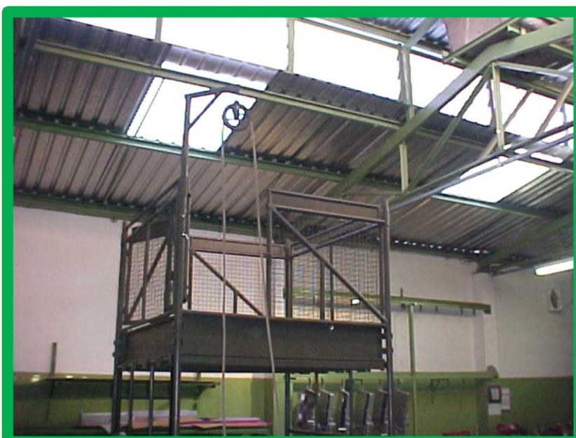
FOTO Nº 03 Sistema de içamento.
