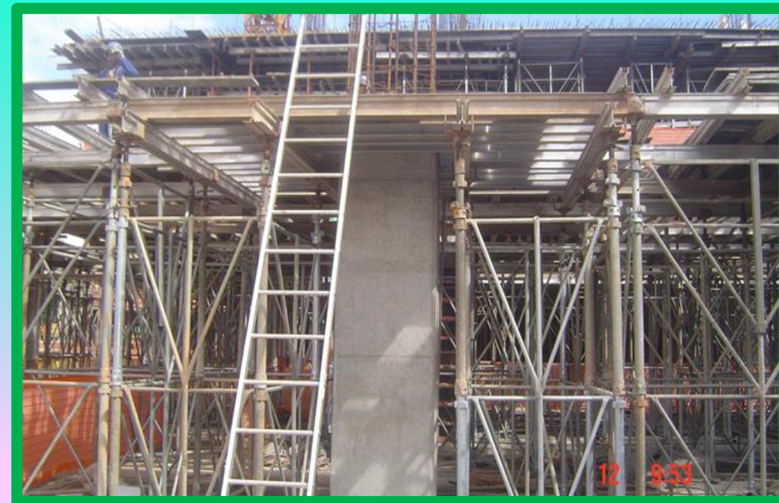
ESCADA DE USO INDIVIDUAL METÁLICA
