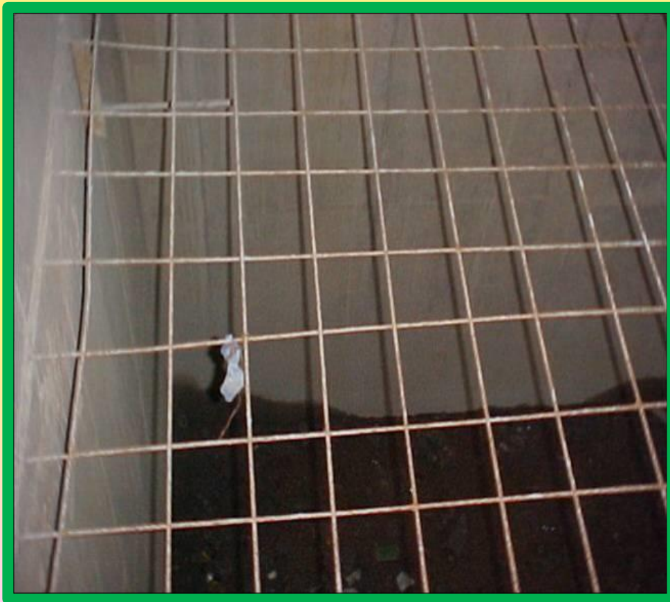
MALHA DE FERRO EM CADA PAVIMENTO
