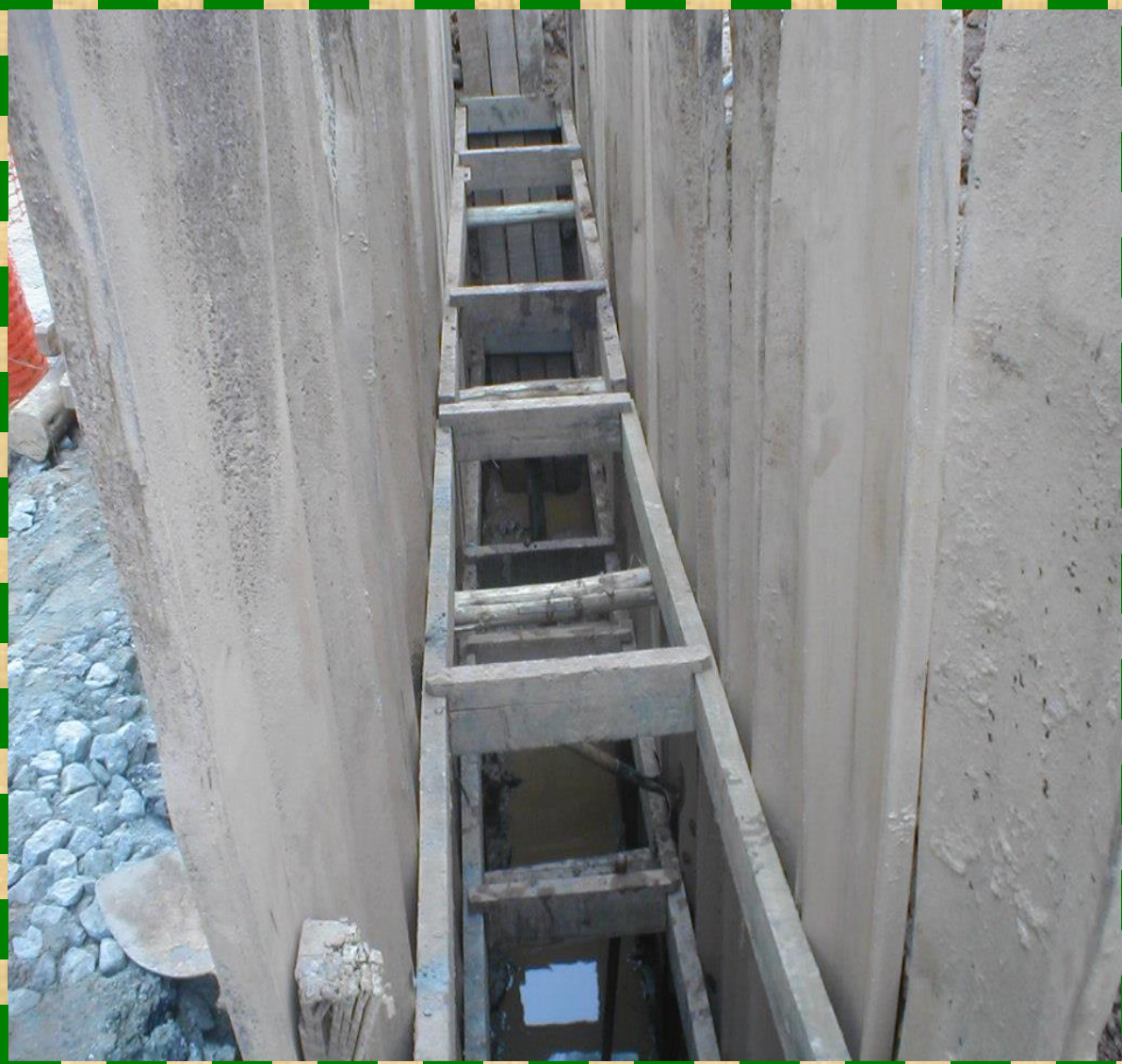
ESCORAMENTO COM PRANCHAS DE MADEIRA
