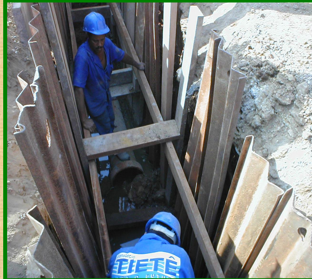
ESCORAMENTO COM PRANCHAS METÁLICAS
