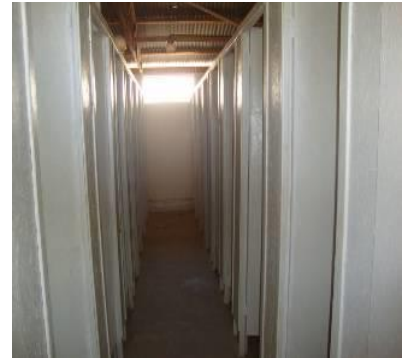
FOTO Nº 07 Gabinete de Chuveiro com divisórias e com porta – 2ª Etapa da implantação.
