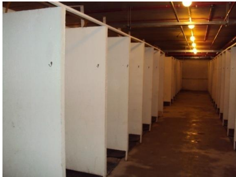
FOTO Nº 06 Gabinete de Chuveiro com divisórias e sem porta – 1ª Etapa da implantação.
